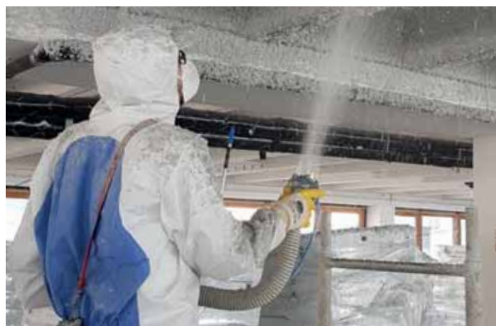
Isolation de murs creux avec tête de pulvérisation Inline/adhésive NW50
